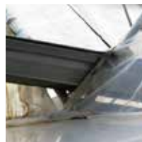
隙間がないか確認
